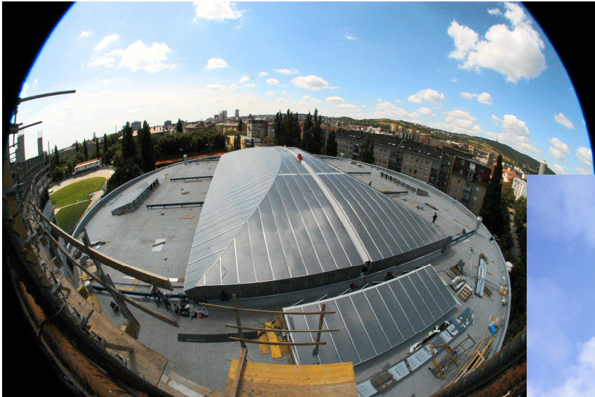
Národné tenisové centrum, Bratislava Výroba a montáž ocelevej konštrukcie, posuvnej strechy
