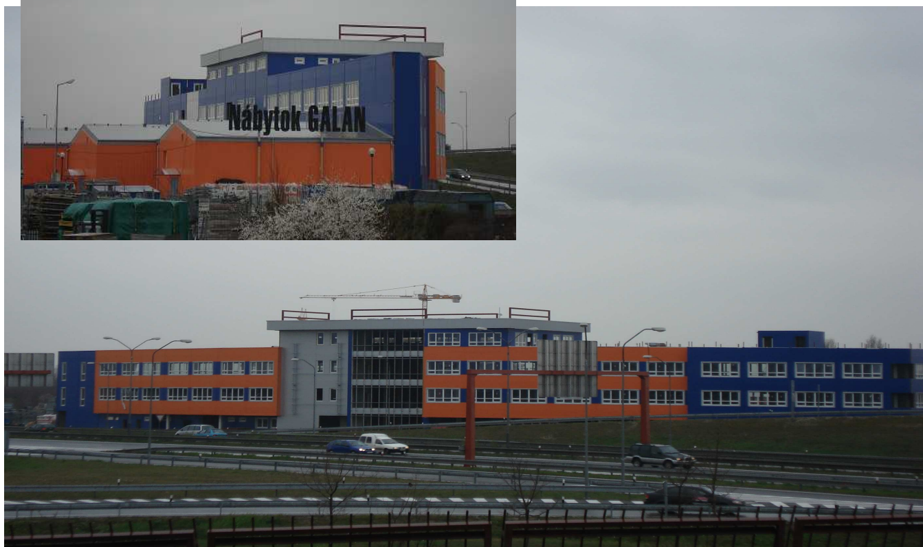
Nábytok GALAN Bratislava HSV práce + výroba a montáž oceľovej konštrukcie
