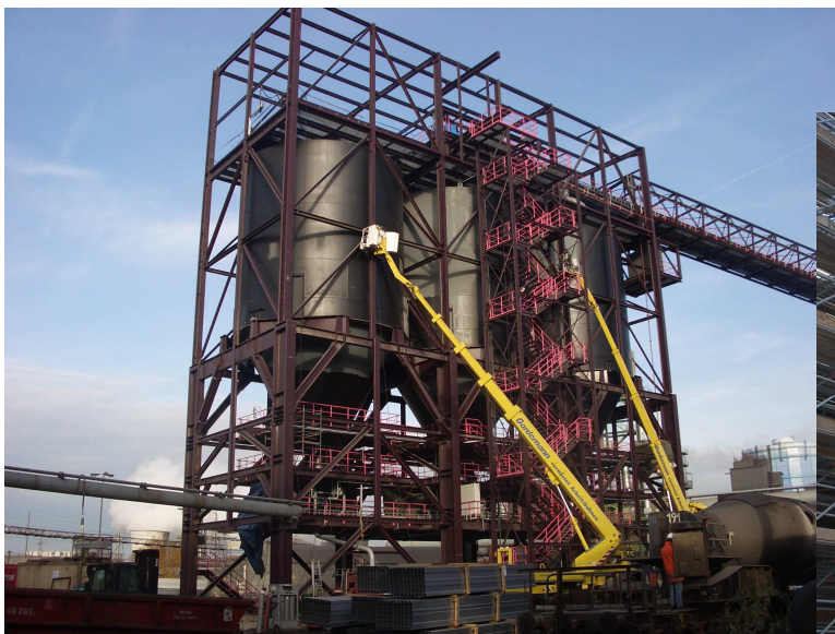
Oceľová konštrukcia, Duisburg Výroba a montáž oceľovej konštrukcie
