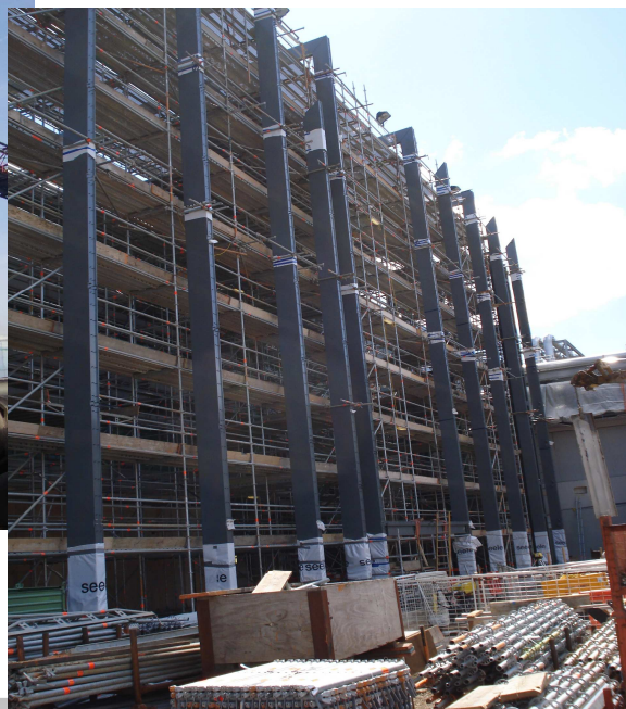
Letisko HEATHROW, Londýn Výroba oceľovej konštrukcie
