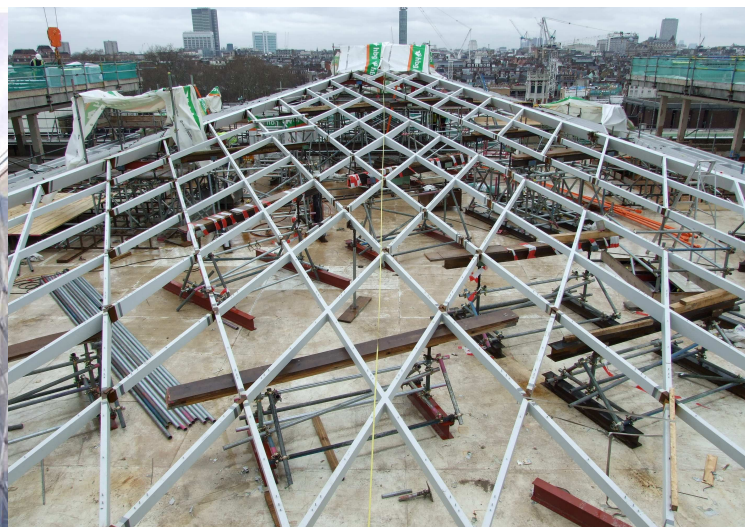
BAKER STREET, Londýn Výroba oceľovej konštrukcie
