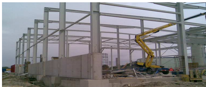
Bioplynová stanica Bošany Dodávka a montáž ocel'ovej konštrukcie, opláštenia a zámočníckych výrobkov
