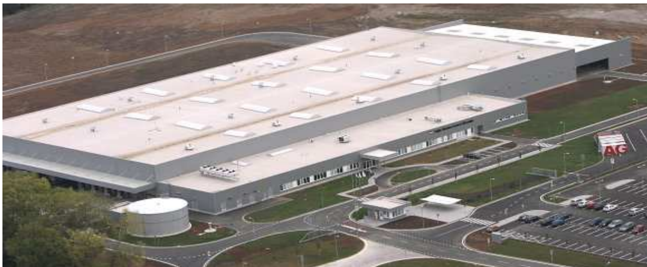
HALLA CLIMATE CONTROL Slovakia s.r.o., Ilava Prístavba skladu balenia
