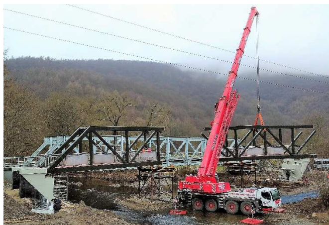
Lávka pre cyklistov cez rieku Vlára Horné Srnie Výroba a montáž OK lávky
